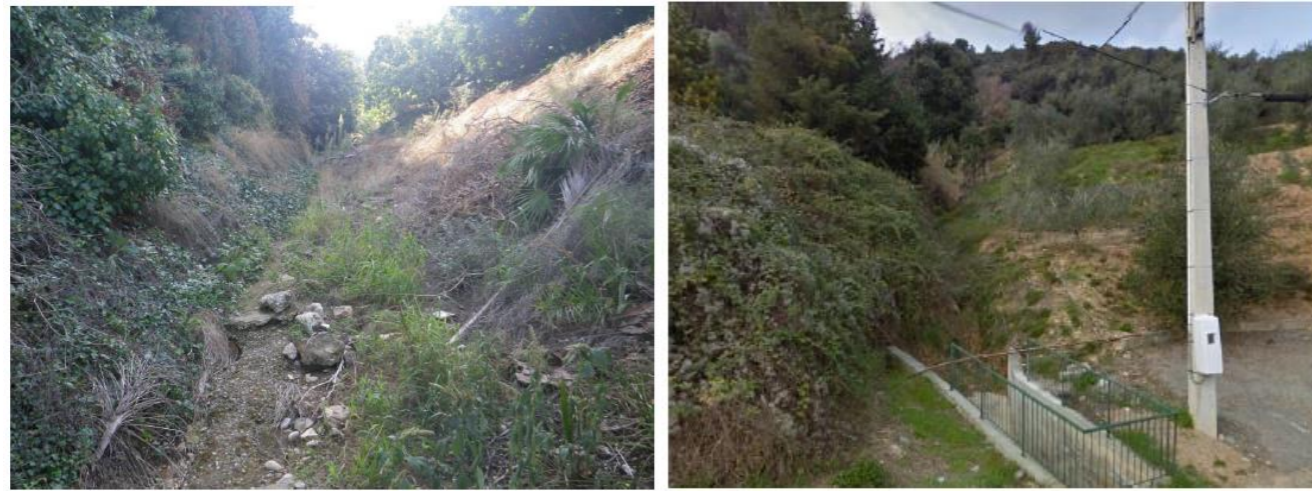
Figure 13 : Vallon des Maoupas partie amont et ouvrage de franchissement du chemin Marcellin Allo (Source : Artelia)
