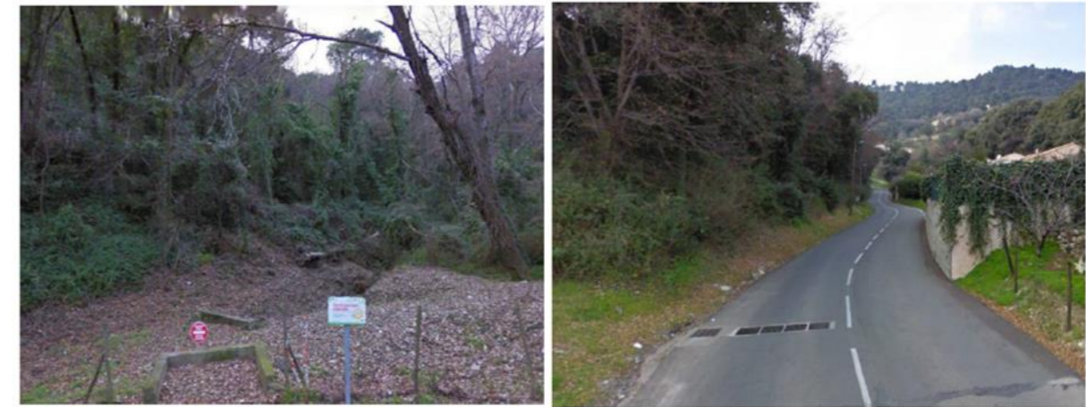
Figure 15 : Vallon de la Baronne naturel partie amont et canalisé sous le chemin Marcellin Allo (Source : Artelia)
